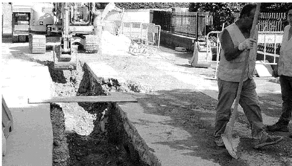
Lavori per realizzare le fognature (Vip)
